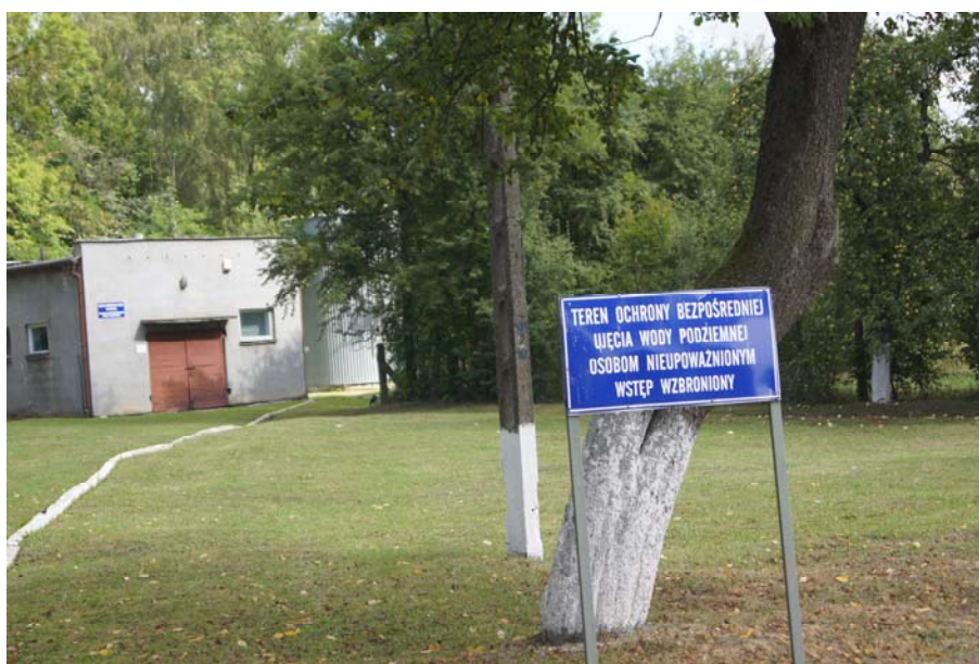
Fot. 12 Gminne ujęcie wody w Jasieniu
