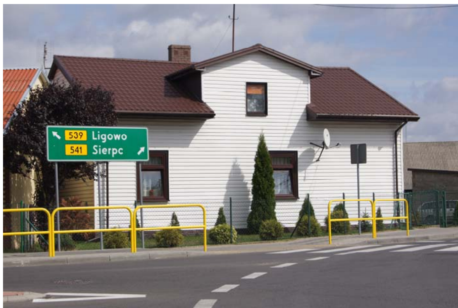
Fot. 43 Dom drewniany z XIX wieku (ul. Sierpecka 1, przebudowany) w Tłuchowie Fot. własna
