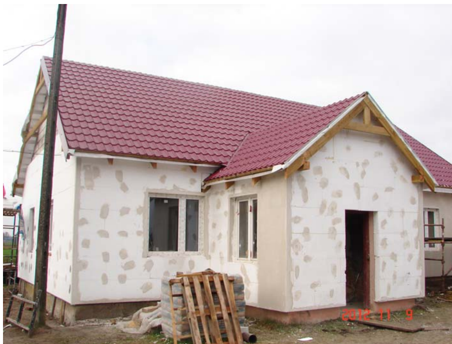
Fot. 53 Świetlica wiejska (zmiana sposobu użytkowania i remont) w Źródłach Fot. Urząd Gminy w Tuchowie
