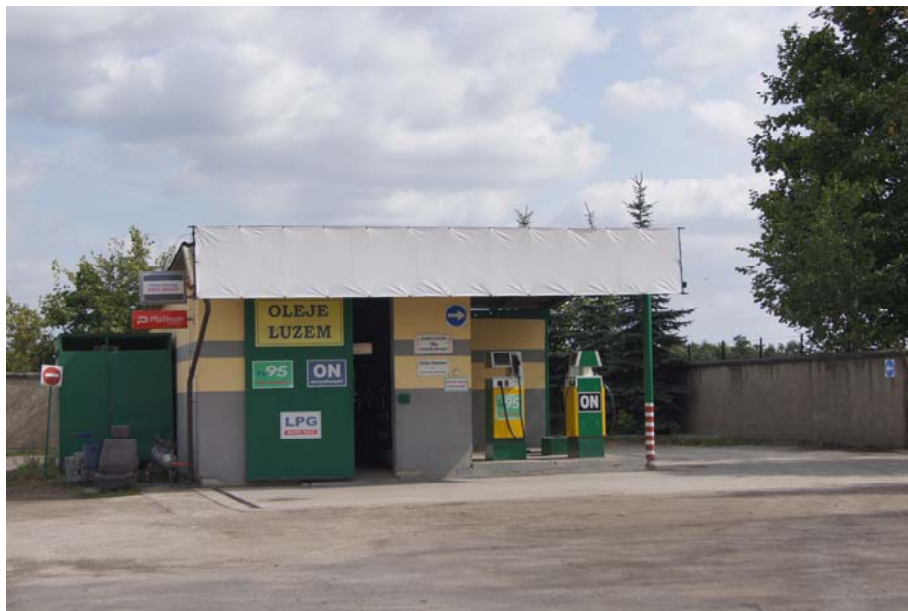
Fot. 30 Stacja Paliw w Tłuchowie Fot. Własna
