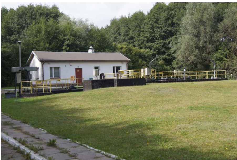
Fot. 16 Gminna oczyszczalnia ścieków w Tłuchowie Fot. Własna
