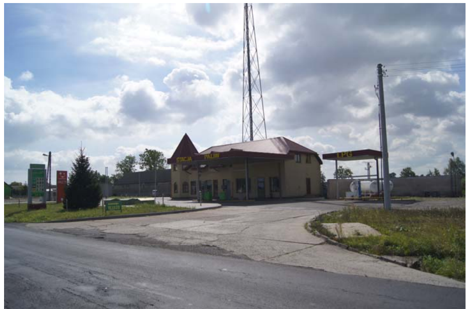
Fot. 15 Stacja bazowa telefonii komórkowej przy stacji paliw w Kamieniu Kotowym Fot. własna
