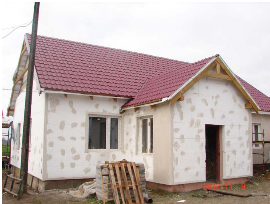
Fot. 26 Remont świetlicy wiejskiej w Źródłach Fot. Urząd Gminy w Tłuchowie
