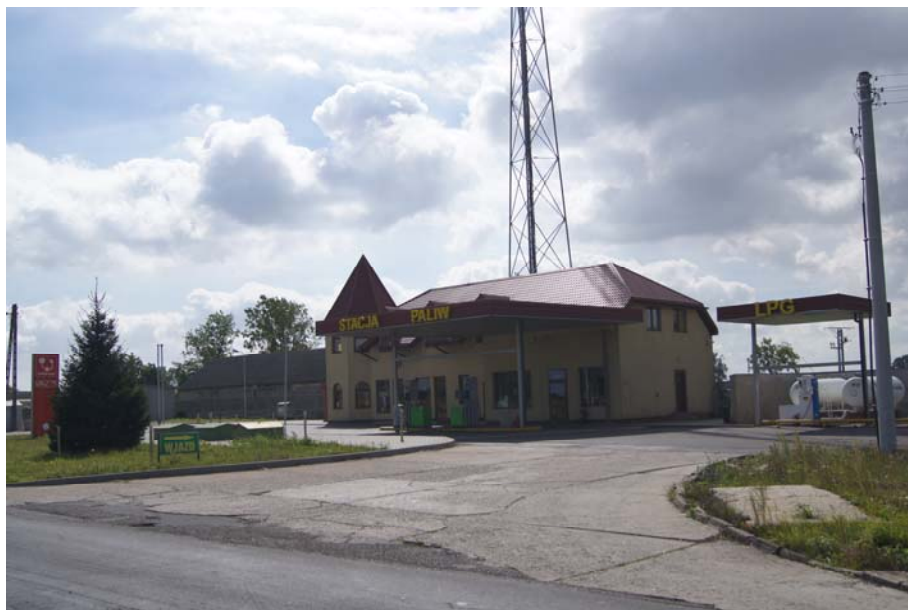
Fot. 31 Stacja Paliw w Kamieniu Kotowym Fot. Własna
