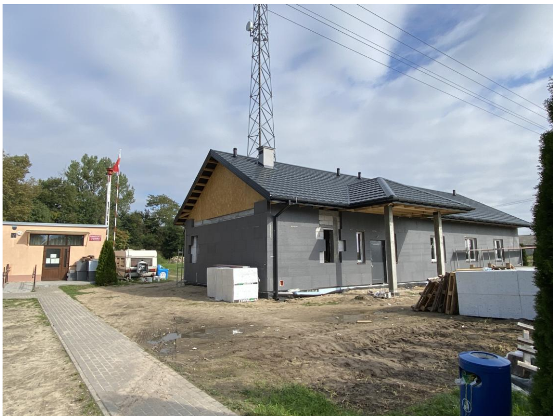
Nowobudowana Świetlica Wiejska w Jasieniu
