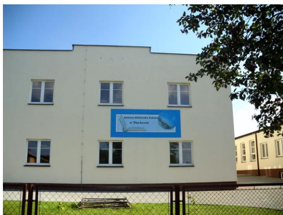
Budynek Gminnej Biblioteki Publicznej w Tłuchowie
