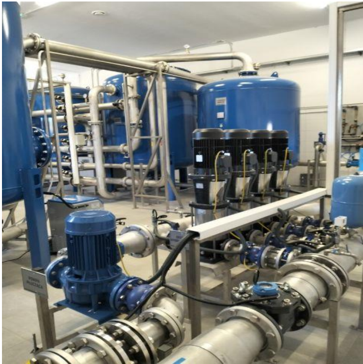
Stacja Uzdatniania Wody w Tuchowie w trakcie budowy
